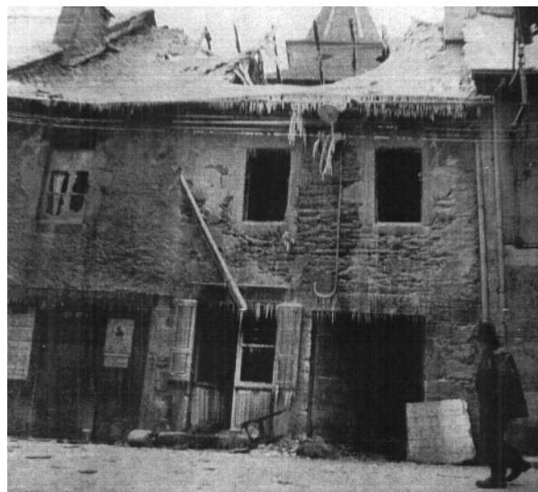
Février 1956 : Incendie au n°8 de la rue des Toiles
